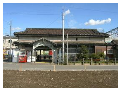
解体前(平成 21 年)
